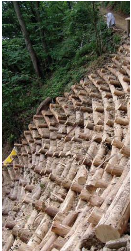
Impiego locale del legname per le sistemazioni idraulico-forestali. (Monte di Portofino - GE)
