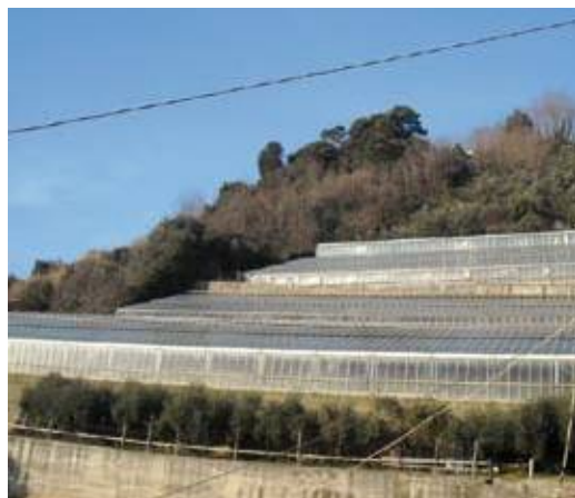
Disposizione dei prospetti a Sud che si presta alle nuove proposte di inserimento di sistemi di captazione dell'energia solare per la produzione di energia (Voltri - GE).
