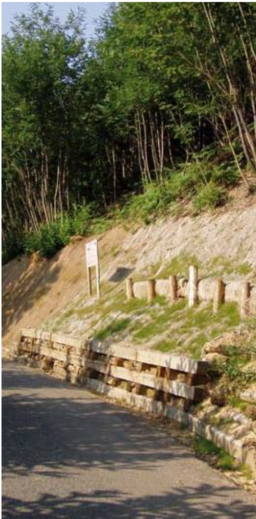
Sistemazione della viabilità di servizio (Campo Ligure - GE).
