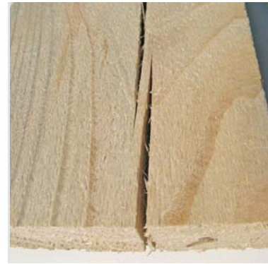
Fessura passante su segato Fente traversante sur sciage
