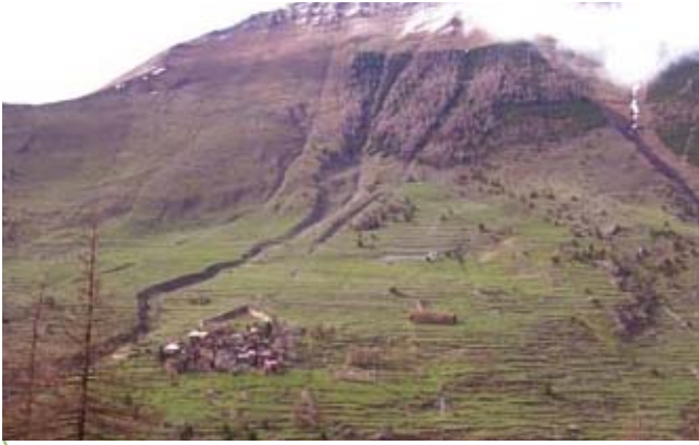
Rimboscimento protettivo e deviatore di valanga a cuneo della metà del 1700 in località Pequerel - Fenestrelle (Torino)
