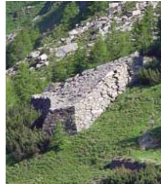
Deviatori di valanga a Saint-Rhémy (Valle d'Aosta - 1841): a pettine parzialmente crollato (sinistra) e a cuneo (destra)
