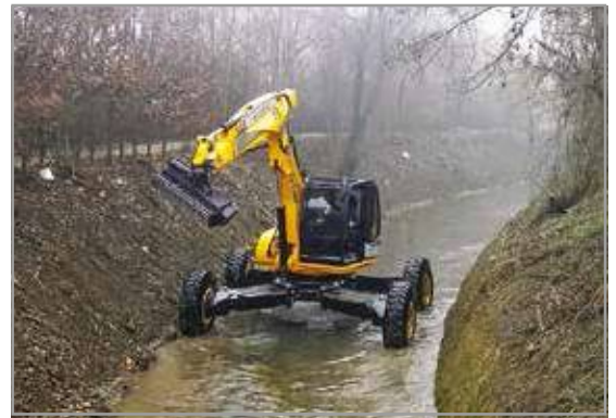
Foto 8 - L'escavatore a ragno Batemag P.100 della Osma, a 2 o 4 ruote motrici (fonte: www.batemag.com ).
