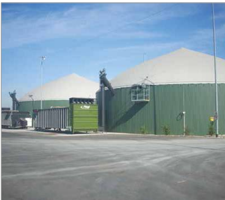
Foto 1 - Impianto a biogas.
