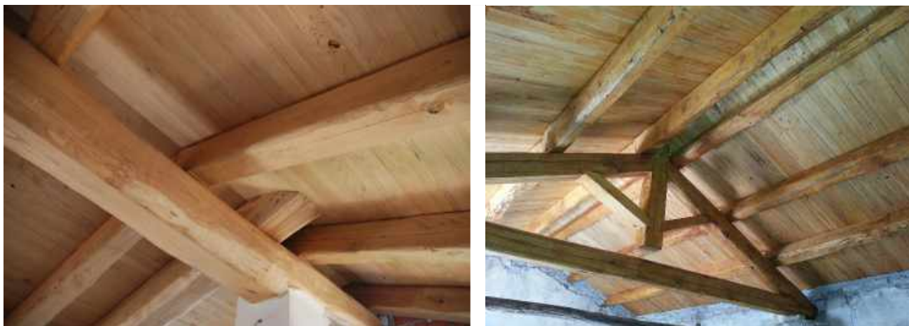
Figura 1. Esempi di coperture lignee (a sinistra e a destra) realizzate con travi Uso Fiume.
