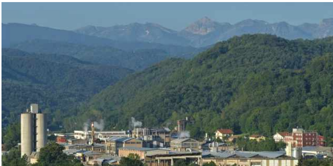
Figura 1. Visione di insieme dello stabilimento produttivo.
