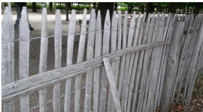
Figura 1. Particolare dell'unione dei vari listelli con filo metallico.
