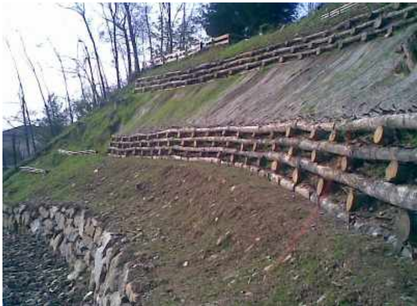
Figura 3. Esempi di impiego della paleria di castagno in interventi di ingegneria naturalistica (sotto) e in vigneto (sopra).
